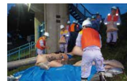
岐阜県岐阜市日置水防団 月の輪工を実施 (平成30年7月8日：長良川左岸)
