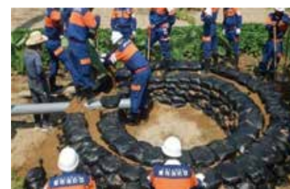
兵庫県豊岡市水防団 金段工を実施 (平成30年7月15日：円山川左岸)
