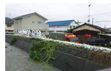
愛知県西条市水防団 積み土のう工を実施 (平成30年7月6日：中山川水系大谷川)
