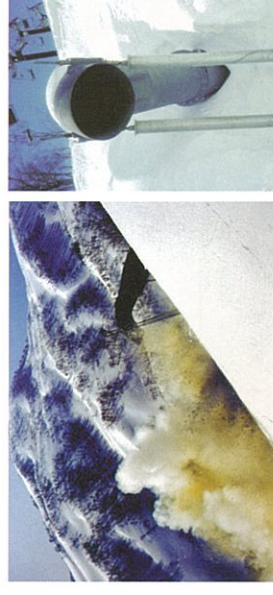
減勢工 大規模な雪崩が予想される所に設置し、雪崩の勢いを弱めます。（新潟県糸魚川市） Energy Dissipator works Avalanche-retarding structures dissipate the energy from moving snow. (Itoigawa City, Niigata Pref.)
