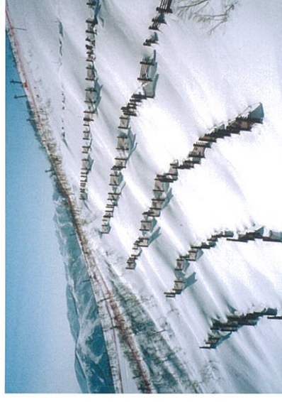
雪崩予防柵 雪崩発生区に設置し、雪崩の発生を未然に防ぎます。（長野県北安曇郡白馬村） Avalanche-prevention fences are installed in avalanche start zones. (Hakuba Village, Nagano Pref.)
