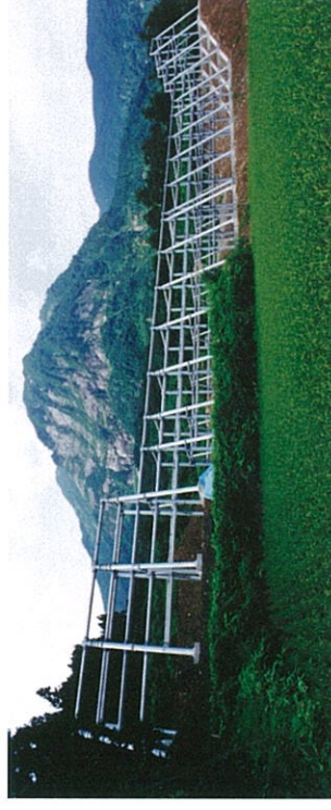
減勢工 大規模な雪崩が予想される所に設置し、雪崩の勢いを弱めます。（新潟県糸魚川市） Energy Dissipator works Avalanche-retarding structures dissipate the energy from moving snow. (Itoigawa City, Niigata Pref.)
